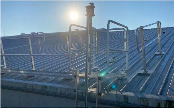
Mit unserer hochwertigen ABS Steigschutzschiene kannst Du problemlos auf Aluminium- und Stahlsteigleitern arbeiten und dabei maximale Sicherheit genießen. Dank mitlaufender Auffanggeräte mit Arretierungstechnik werden Anwender\*innen im Sturzfall zuverlässig gesichert. Pro Auffanggerät sichert das System 1 Person, insgesamt können bis zu 2 Personen das System zeitgleich nutzen.
