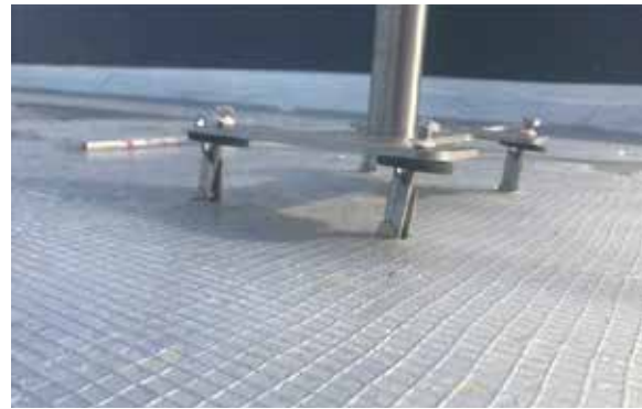
Grundplatte eines Anschlagpunktes mit Kippdübeln
