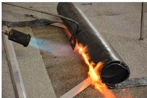
Rechts: Die Abdichtmanschette für den Anschlagpunkt wird verschweißt
