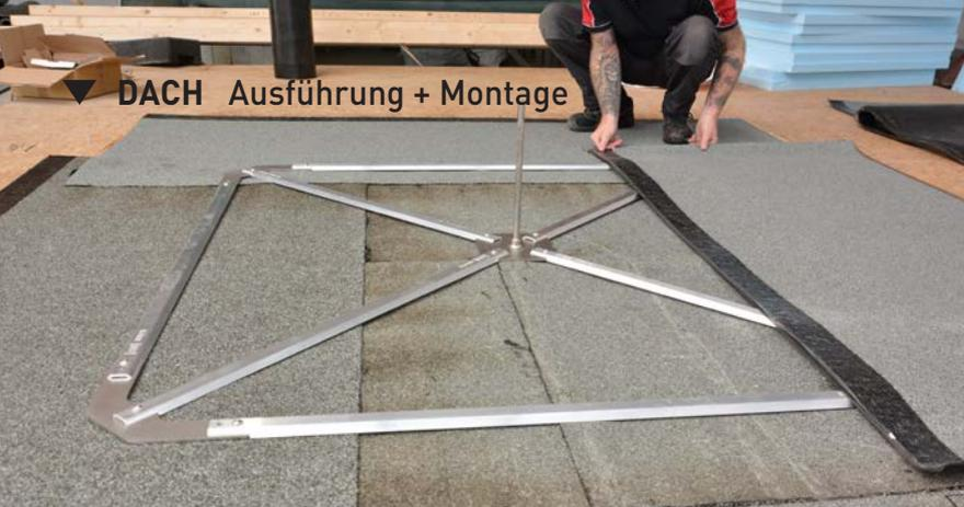
Ein Aluminiumrahmen bildet die Basis des Anschlagpunkts. Er wird nach dem Zusammensetzen mit Bitumenbahnen abgedichtet
