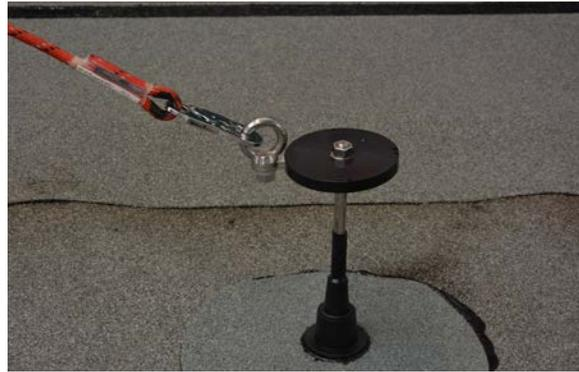
Nach der Montage der Anschlagöse für die PSAgA ist der „ABS-Lock OnTop Max“ einsatzbereit
