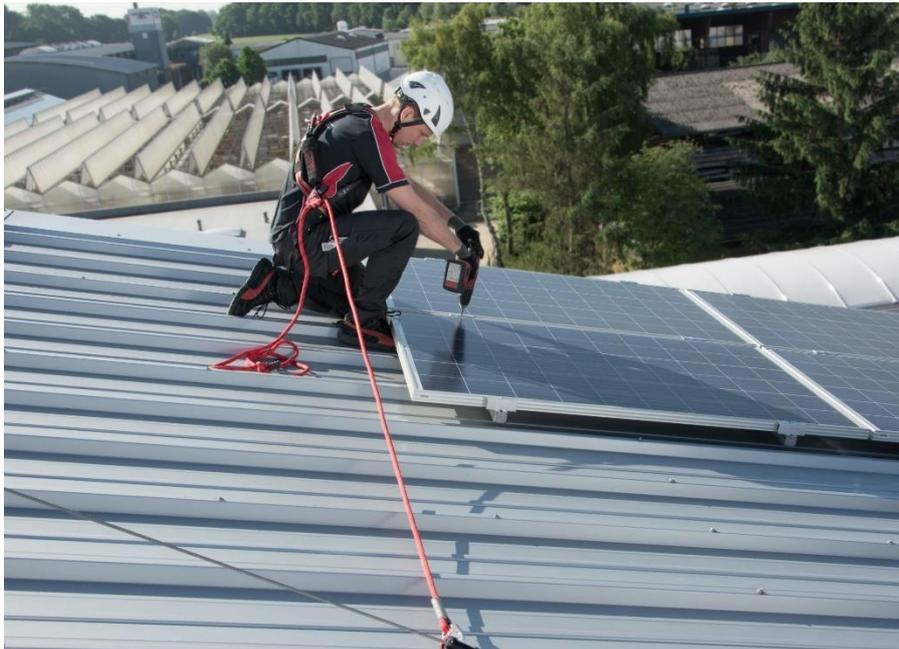
**„Seilsicherungssystem mit Zulassung des DIBt für das Falzdach“**
