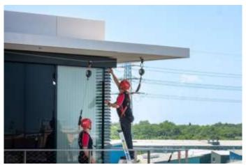
"Die neuen Höhensicherungsgeräte von ABS Safety halten bis zu 140 kg sicher."
