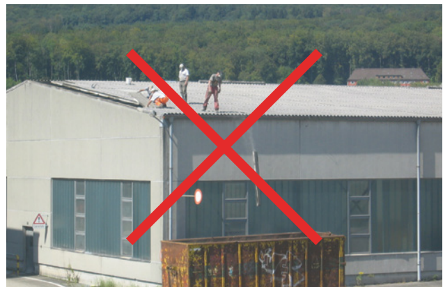
1 und 2 Grobfahrlässiges Verhalten beim Arbeiten auf Faserzementdächern und im Bereich von Lichtplatten
