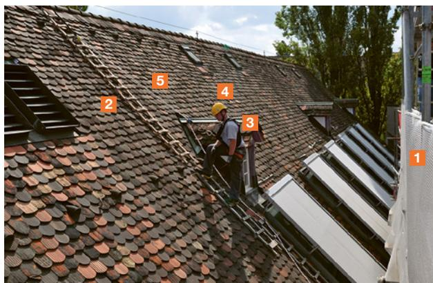
12 Arbeitsplatz-Positionierungssystem auf einem geneigten Dach
