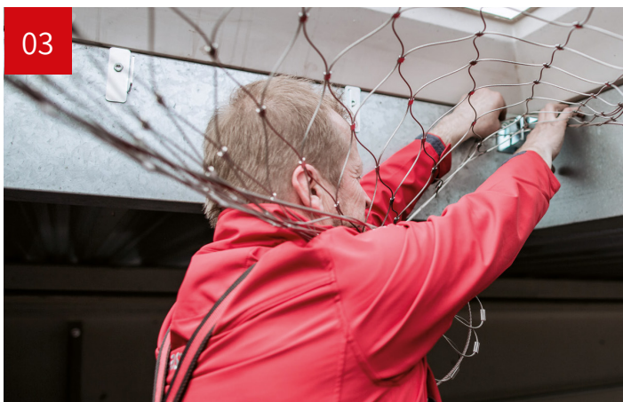
03 Eckteil nach vorne ziehen und Netz einhängen
