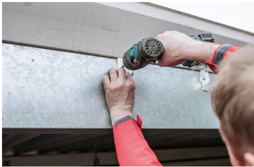
2.) Befestigung der Halterungen mittels gelieferter Schrauben
