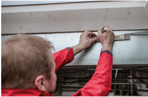
1.) Positionierung der Halterung gemäß der Tabelle
