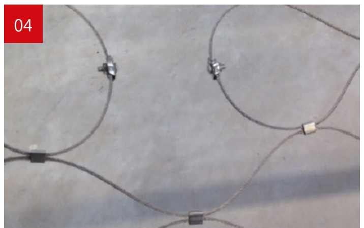
Achtung! Gewinde und Mutter müssen in die geschlossene Netzmasche zeigen
