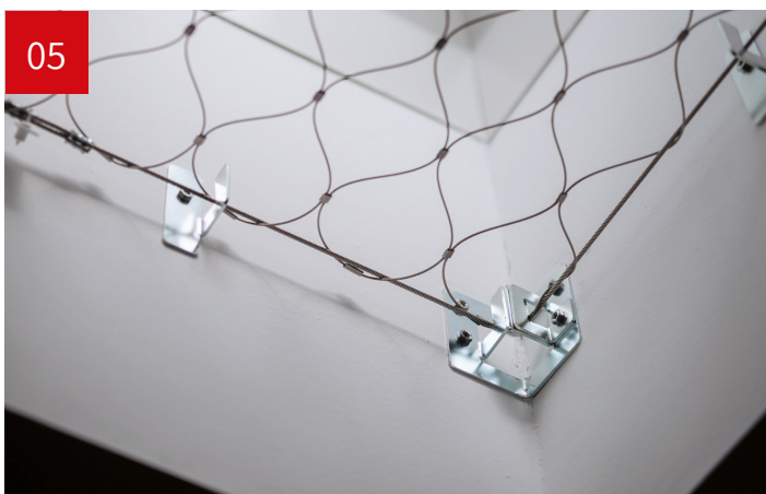
05 Randseil am Montagende beim Eckteil, wenn nötig mit einem Spanner nachspannen! nach links: Spannung erhöhen nach rechts: Spannung reduzieren
