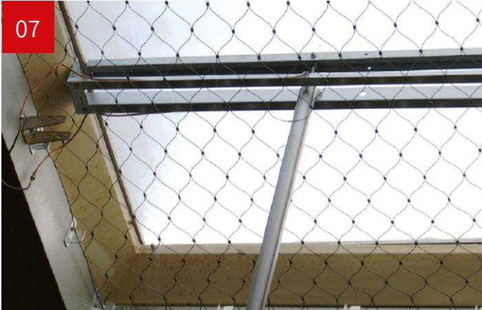
07 Öffnung für Zylinder ggf. ausschneiden
