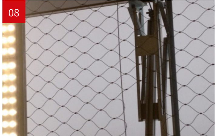
08 Wenn erforderlich zusätzliches Tragseil einfädeln → Litzen wieder verpressen → mit Simplex-Klemmen verschrauben oder mit Hülsen verpressen. Wenn nötig zusätzliches Tragseil einfädeln
