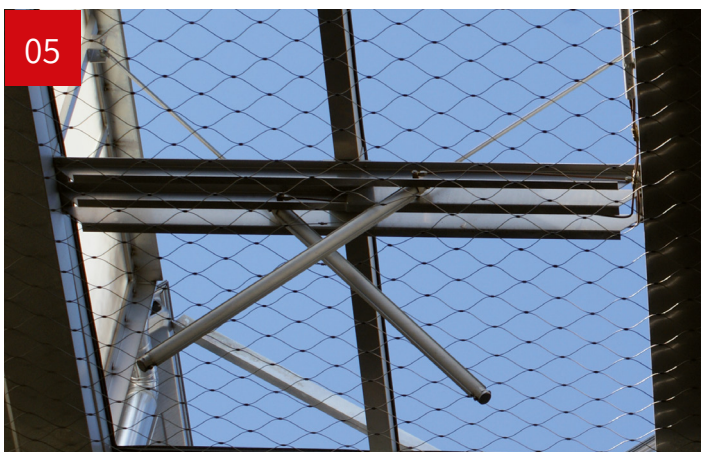
Wenn Zylinder vorhanden ist, Lichtkuppel öffnen, damit der Schwenkbereich des Zylinders festgestellt werden kann.
