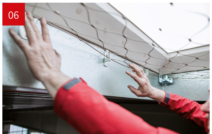
Netz einhängen und ausrichten
