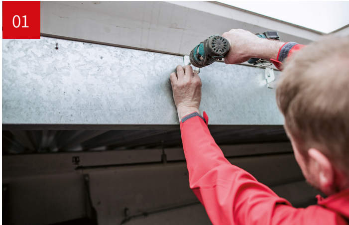
01 Alle Eck-, und Mittelteile mit den gelieferten Schrauben befestigen
