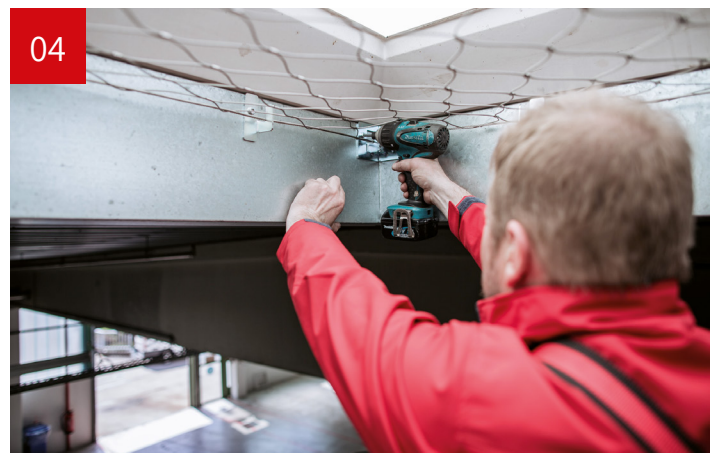
04 Gelöste Schraube fest anziehen → entfernte Schraube wieder befestigen → Verwenden Sie ggf einen Schraubenzieher zum einhängen des Netzes (Hebelwirkung)
