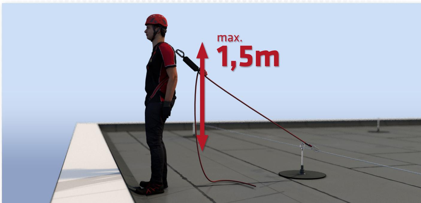
Ein Seilsystem, das 1,50 m entfernt zur Absturzkante verläuft, kann noch als ein Rückhaltesystem angewandt werden. Hierbei ist es wichtig, dass ein sicherer Zugang (außerhalb von 2,00 m zur Absturzkante) gewährleistet wird.
