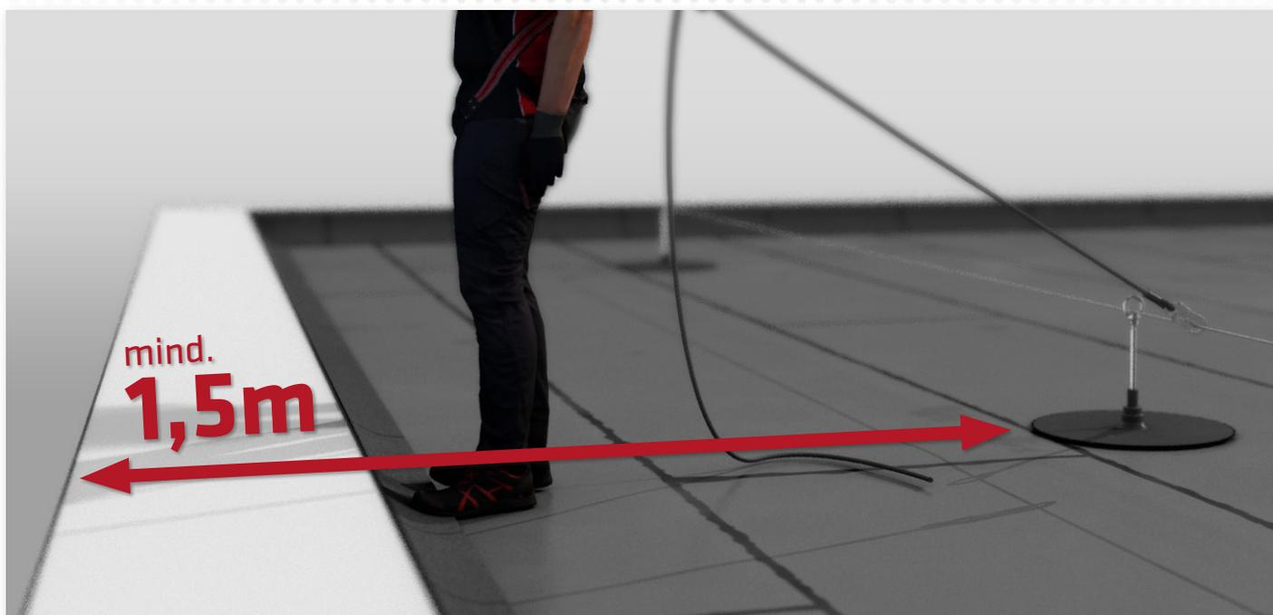
Dies ist möglich weil man davon ausgeht, dass die Rückenöse des Auffanggurtes maximal 1,50m über dem Seilsystem verläuft. Mit entsprechend gekürztem mitlaufenden Auffanggerät kann man so noch aufrecht stehen; ein Sturz über die Kante wird jedoch vermieden.
