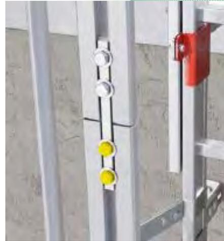
Bild 5: Rückenschutzstrebe mit Verbinder
